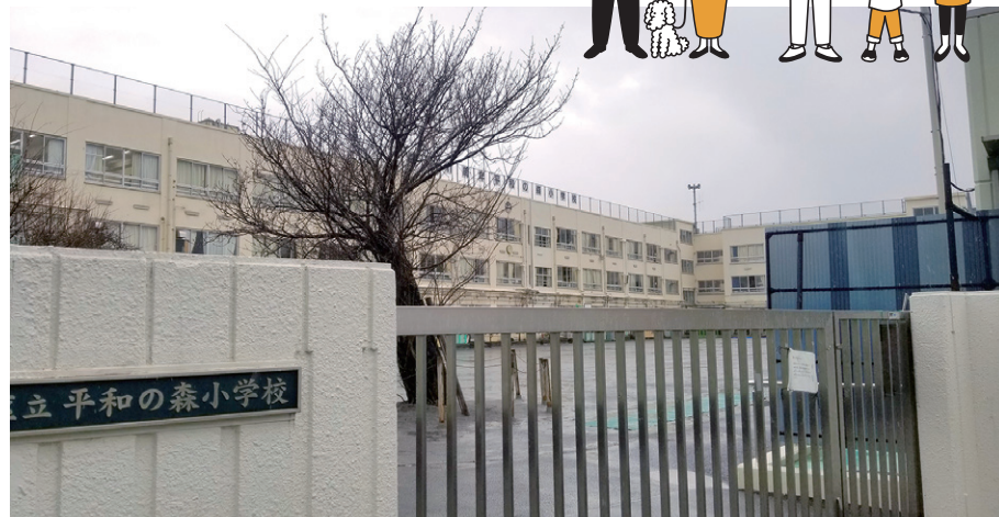
最終的に売却予定となっている平和の森小の用地
